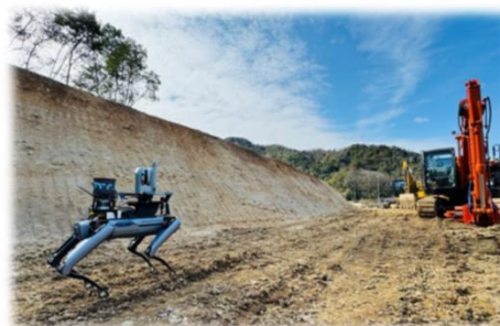
施工管理効率化の取り組み <砂防工事現場における4足歩行ロボットの活用>
