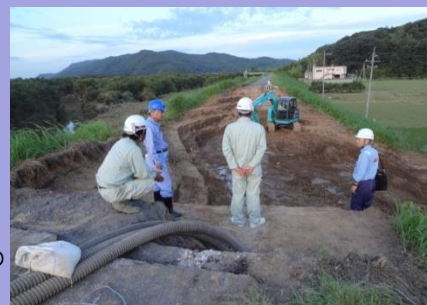
被災現場での打合せ状況
