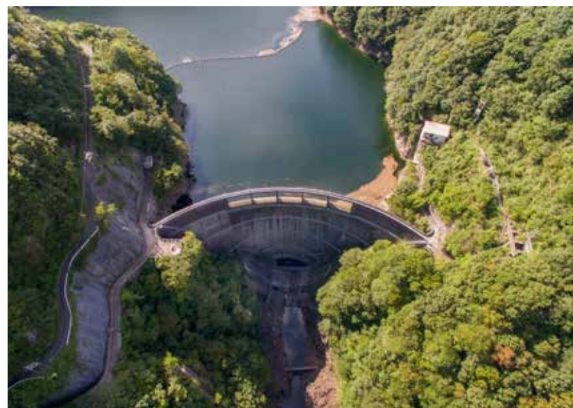
佐々並川ダム（堤高67.4m、堤頂長127.3m） 堤頂幅2.5mで美しい曲線の特徴としている。奥に取水設備が見える。
