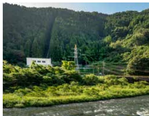
佐々並川発電所 発電を終えた水は、前を流れる阿武川に戻される
