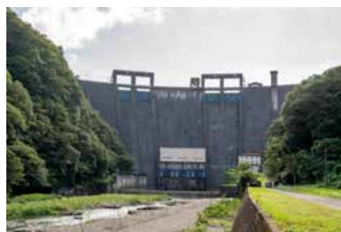
「阿武川ダム」（堤高95m、堤頂長286.0m） 山口県では最大規模のダム。重力式アーチダムは珍しく国内では10例程。その中で堤高第2位、総貯水容量第1位である。
