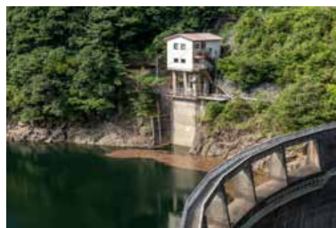
佐々並川ダムの取水設備 ダムの水は阿武川発電所下流の佐々並川発電所に送られる
