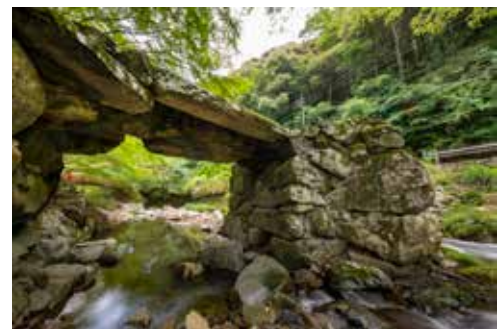
中央の大きな橋脚が安定感を漂わせる
