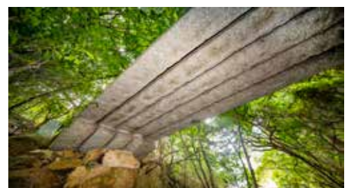
濱井橋(橋長9.3m、橋幅1.8m)の桁
