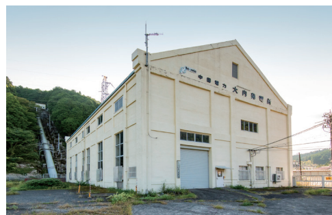
大内発電所(旧河合発電所) 大正時代の水路式発電所としては平均的な規模のものだが、大きな河川が少ない中国山地の水力発電所の能力としては、1,000KW級は大きな部類に入る
