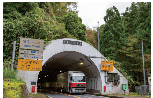
国道 9 号 蒲生トンネル（鳥取県側） 延長 1,745.0 m 幅員 8.0 m
