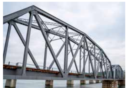
トラス桁は上弦が折れ線で中央が高くなった曲弦ワーレントラスで、2格間ごとにおれている
