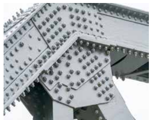
当初はリベットで接合されていたが、傷んだ箇所はボルトに取り替えてある
