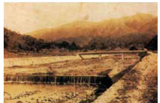
島根県初の砂防事業（昭和10年、横田町大馬木川の流路工）【島根県 しまねの砂防ホームページより】
