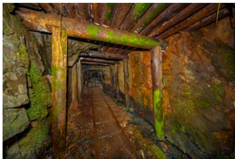
久喜銀山水抜間歩 周辺間歩の水を抜くための間歩。大横谷間歩の坑道で掘られた鉱石もこの坑道を通り製錬所に運ばれた。
