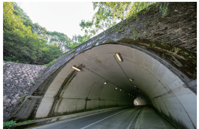
包ヶ浦隧道のバイパスとして平成元年10月完成した杉之浦隧道 (L = 113.0 m、W = 6.50 m)
