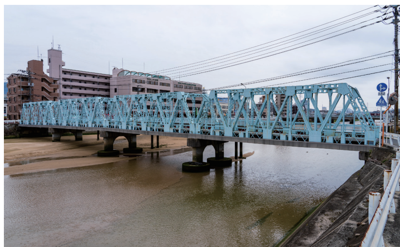
九十九橋 橋長75.0m、幅員4.7m 4径間単純鋼下路式ワーレントラス橋
