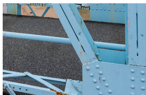
銃弾の跡や利用されていないボルト穴が見える部材
