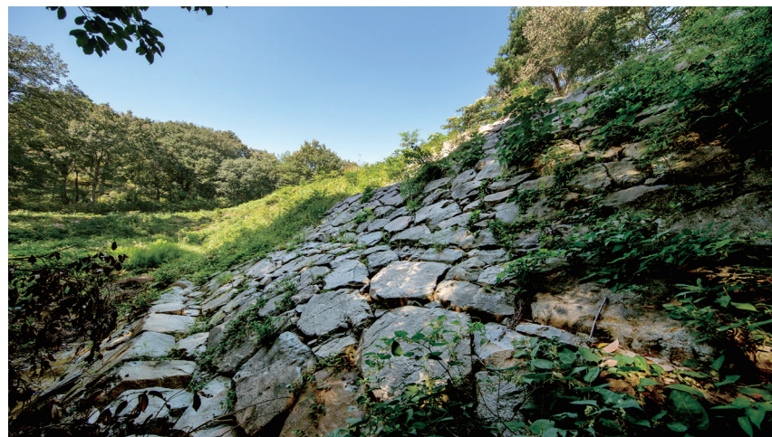
俄谷御趣法砂留 上2段は緩アーチ、下2段は直線、全4段の砂留(石壁堰堤形式 H8.4m L=66.0m)
