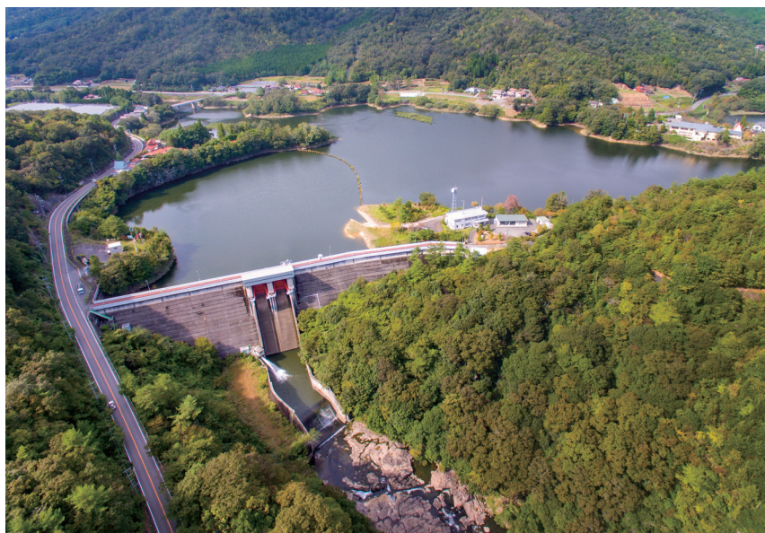
椋梨ダム(重力式コンクリートダム、堤高39.5m、堤頂長213.4m)
