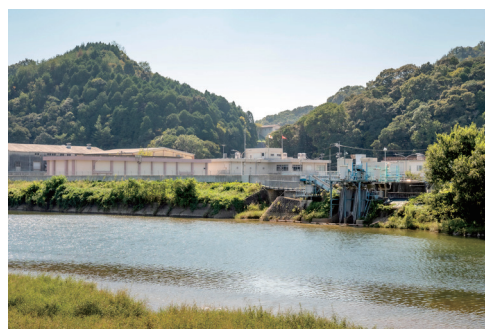
沼田川水道用水供給水道「本郷浄水場」
