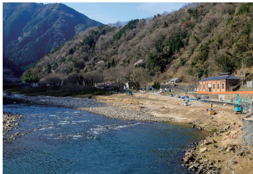
太田川を前にして立つ旧亀山発電所(令和3年3月撮影)
