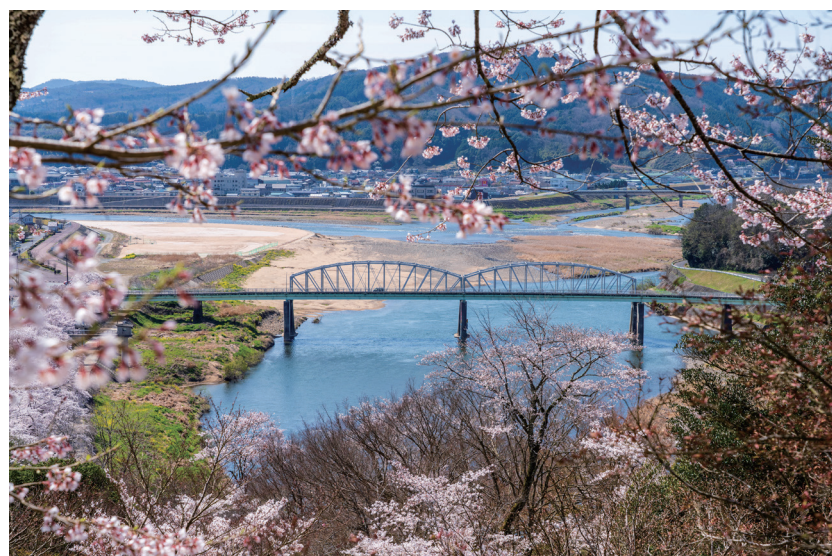
昭和34年太田川から架け替えられた祝橋の中央トラス 橋長210.0m 幅員5.5m 最長スパン51.0m トラス長101.1m、支間長50m、2径間RC桁下路2連続曲弦プラットトラス橋単RC桁
