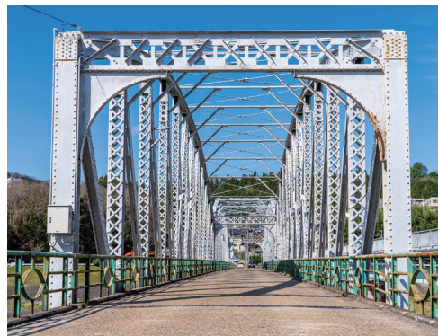
内側から見たトラス部分
