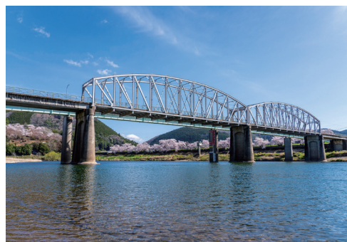
川幅に合わせて太田川橋のトラスの両側にコンクリートガーダーが繋がれた祝橋
