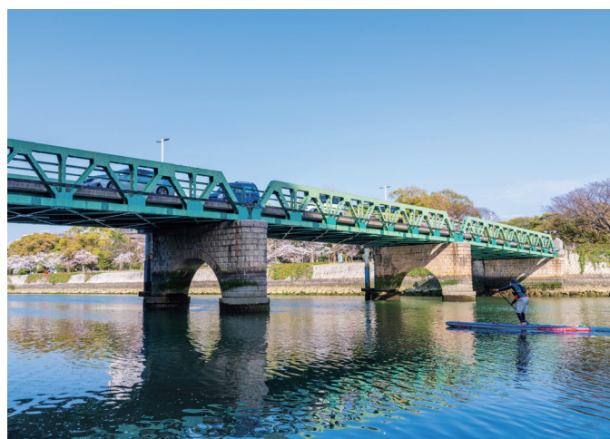
本川橋 橋長73.2m、幅員6.6m 鋼板トラス橋
