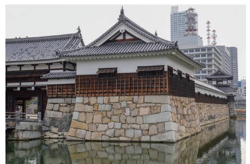
二の丸太鼓櫓の石垣の隅は江戸時代になって用いられた算木積みである
