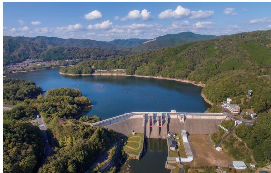
土師ダム（高さ50m、堤頂長300m、重力式コンクリートダム） 本体工事に着工した昭和45年はわが国のダム施工技術が発展した時期で、機械化施工、施工精度の向上など、それまでの施工技術がいかされた。
