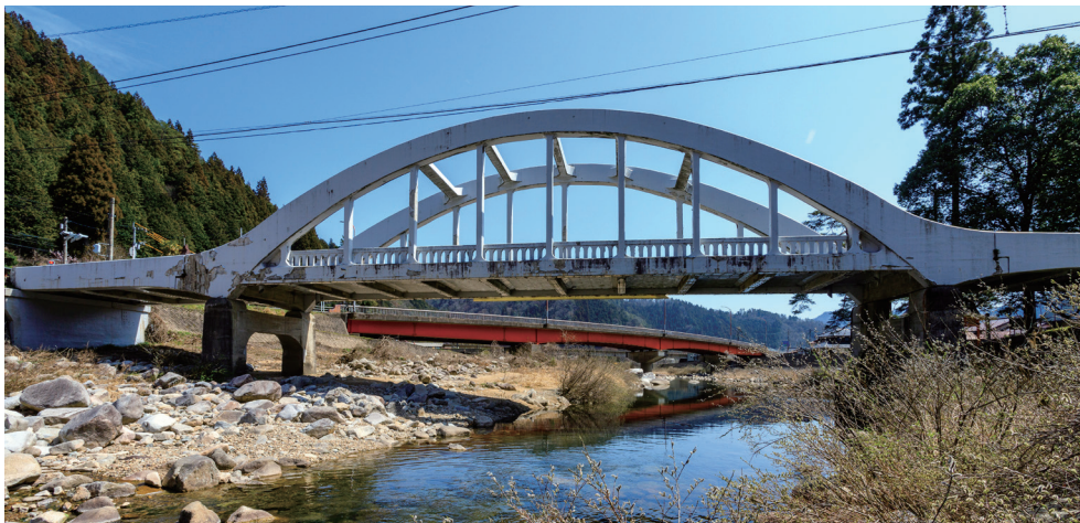
出合橋（橋長 52.5 m、幅員 6.8 m） 平成 23 年に床版の補強を実施、後部に見える赤い橋は新明神橋（国道 191 号）。
