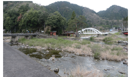
太田川と柴木川の合流点 中央部に滝御前神社、白い橋が出合橋、左手の桁橋が明神橋
