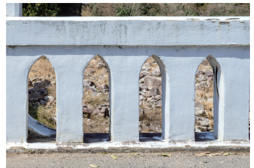
出合橋の高欄
