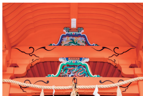
室町の風格と桃山彫刻を具備した葺股 (塗り直しが行われた葺股周囲の平彩色・彫刻彩色)
