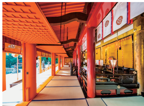
丹塗・胡粉塗・黄土塗・緑青塗・墨塗・朱漆塗・黒漆塗（金箔押し）など塗り直し行い、銚金具の補習を行った
