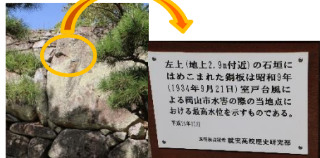
岡山城の石垣にはめ込まれた浸水位標識と説明板
