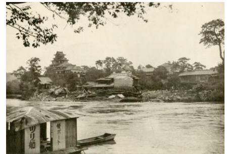
岡山市桜の馬場(現・丸の内)の決壊箇所
