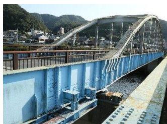
方谷橋（昭和12年完成）
