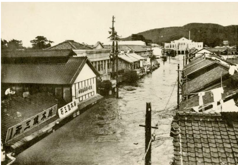
岡山市内山下、公会堂通り(現・県庁通り)の浸水状況
