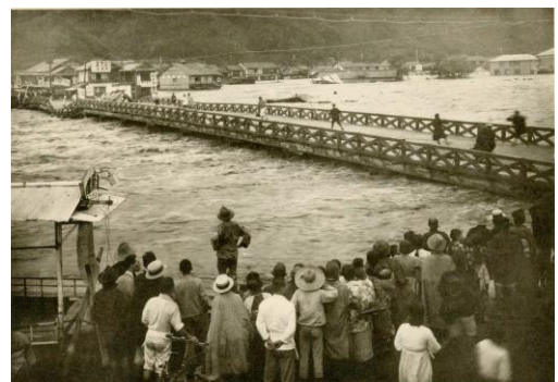
津山市、流出寸前の今津屋橋
