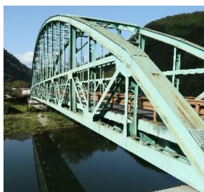
田井橋（昭和12年完成）
