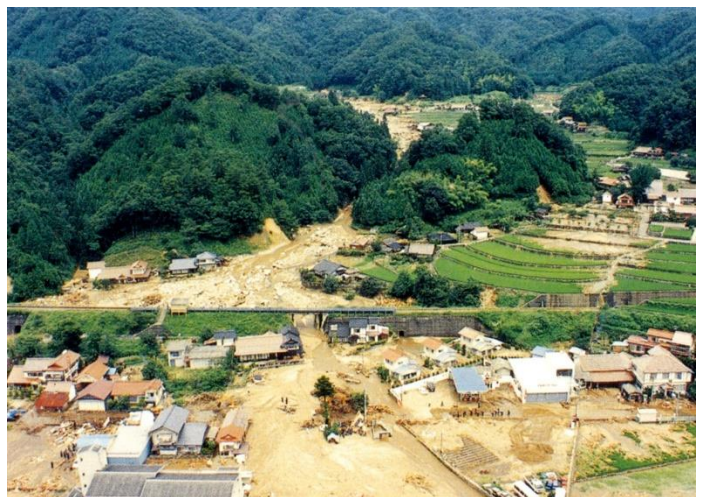
10人の犠牲者を出した江河内谷川の土石流（安芸太田町下殿河内）【広島県土木建築部「県北西部豪雨災害（速報版）」による】
