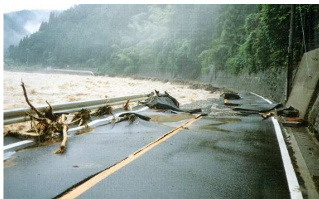
柴木川の増水により流失した国道 191 号 (安芸太田町遊谷字野為)
