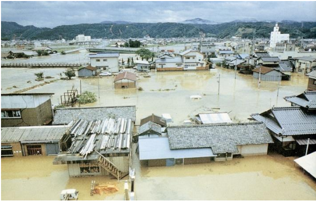
益田川の氾濫で一面が浸水した益田市街地 (島根県益田市あけぼの本町)
