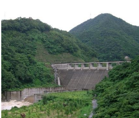
小規模出水時の益田川ダム
