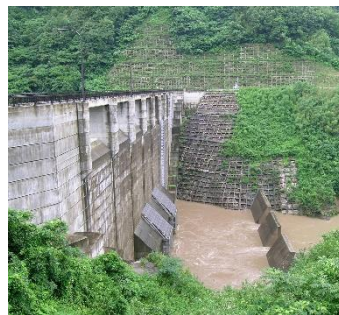
流木補足工や閉塞防止施設を備えた常用洪水吐のあるダム上流側
