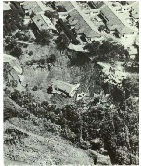
邑久光明園の建物の被害（岡山県土木部防災砂防課・砂防資料室サイト）
