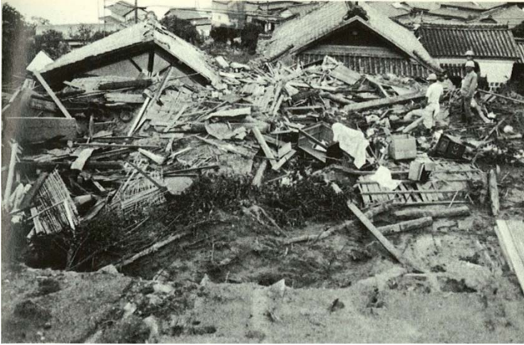
笠岡市北木島の家屋の被害（岡山県土木部防災砂防課・砂防資料室）
