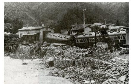
広島県安芸太田町旧加計駅付近の被災状況
