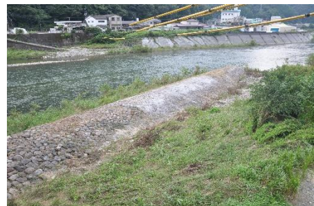
落合橋下の猿尾堤（岡山県高梁市落合町）
