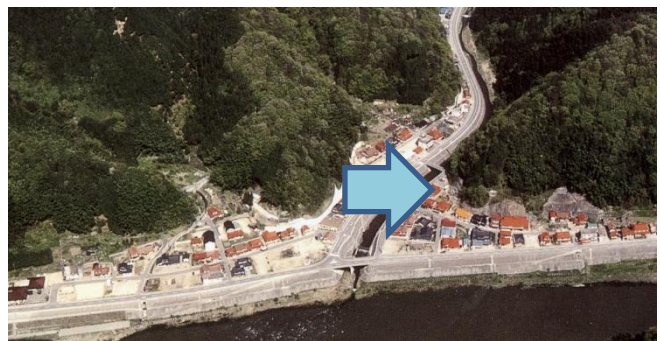
嵩上げ方式による改修完成後の港地区
