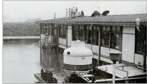
昭和47年7月災害時、事務所の屋根に避難する建設省職員（広島県三次市十日市西） 状況は違うが助磊はこういうイメージの役割
