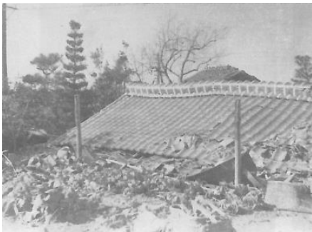
全壊した家屋(岡山市三幡付近)
