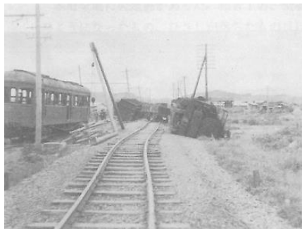
折れ曲がった線路と倒れた列車(玉野市八浜付近)
