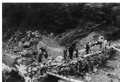
堰堤のコンクリートを野面石で包む
