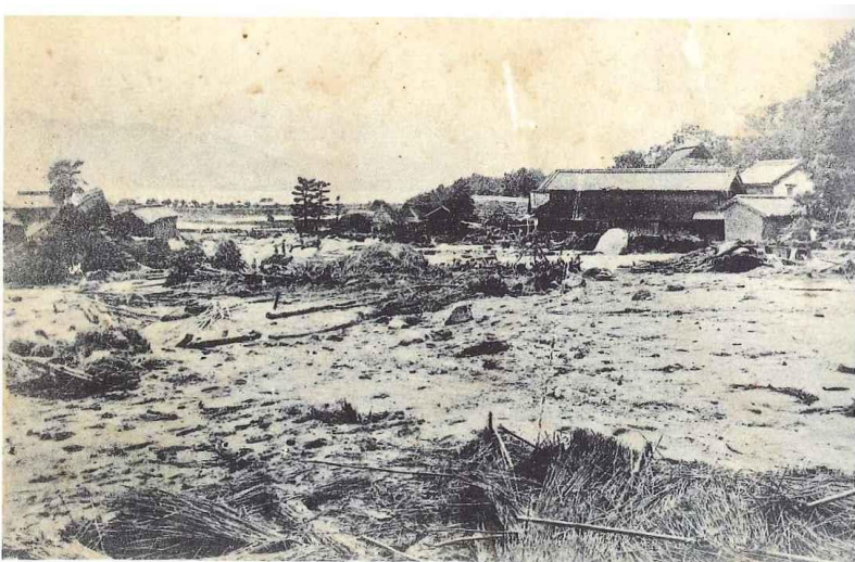
安芸郡坂村(現、坂町)小屋浦の被害状況
