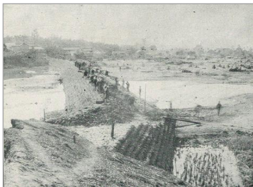
川辺村（現・倉敷市真備町川辺）の堤防修復状況【出典：内務省「高梁川改修工事概要」】
