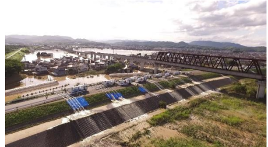
排水ポンプ車による浸水地域の緊急排水（岡山県倉敷市真備町）
