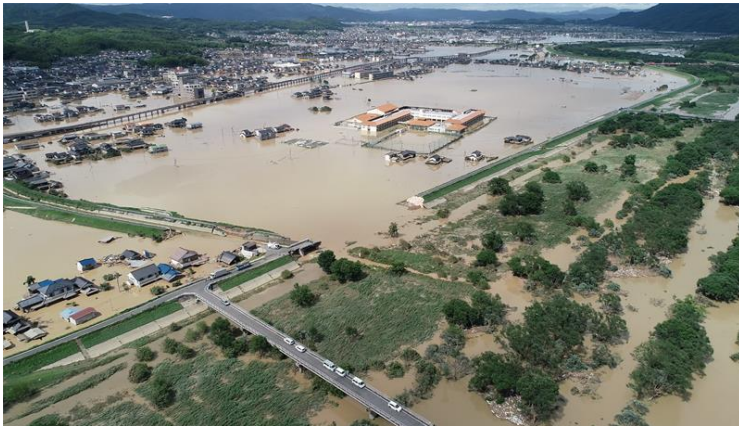
小田川や支川の堤防決壊により浸水した岡山県倉敷市真備町の一帯
