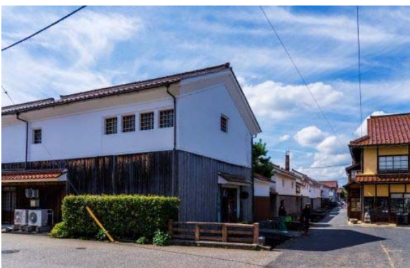
修復を終えた白壁土蔵群の赤瓦三号館(2023年)
