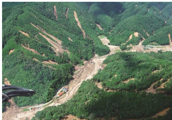
上空から見た庄原市川北町篠堂の被災地
