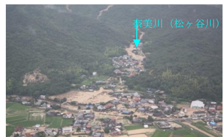
土石流の被害を受けた奈美地区 （奈美川（松ヶ谷川）：防府市大字奈美） 【国土交通省中国地方整備局山口河川国道事務所蔵】
