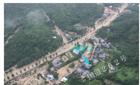
土石流が流下する国道262号 （神里川：防府市大字下右田） 【国土交通省中国地方整備局山口河川国道事務所蔵】
