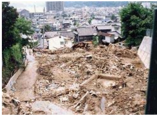
呉市吉浦東町のがけ崩れによる被災 (土砂災害ポータルひろしま/広島県から)
