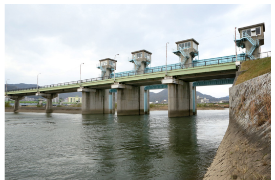
下流左岸から見る大芝水門
