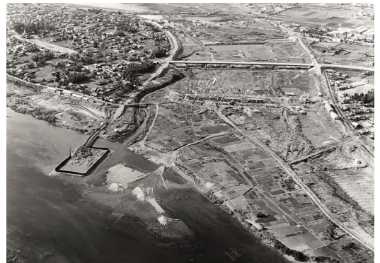
祇園水門着工当時（昭和37年）
