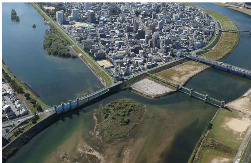
太田川放水路の要「大芝水門と祇園水門」（平成27年） 太田川から市内派川への分岐となる大芝水門（左）、放水路への分岐祇園水門（右）から下流を望む。
