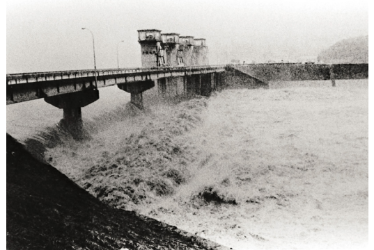
可動堰全開の祇園水門（昭和47年7月豪雨時）
